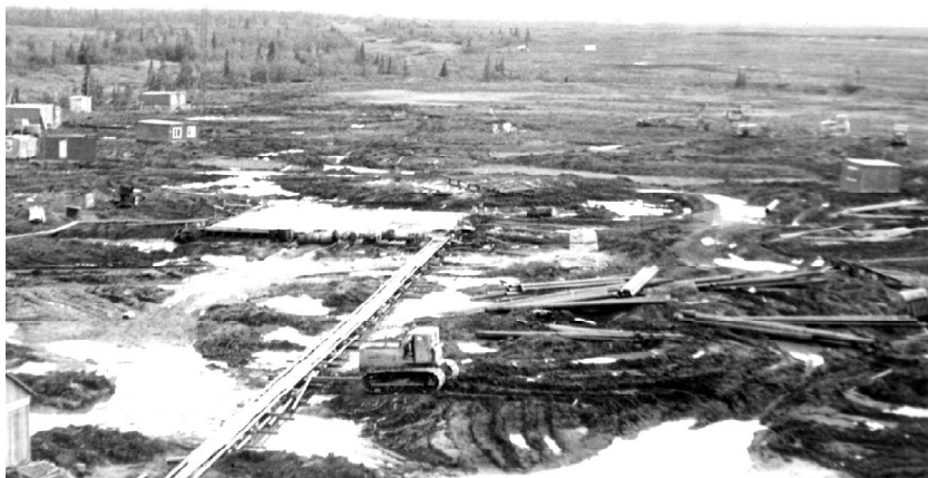
Рис. 7.9. «Перехват» поверхностного стока мерзлотной верховодки и техногенное заболачивание буровой площадки Сандивей-21.
